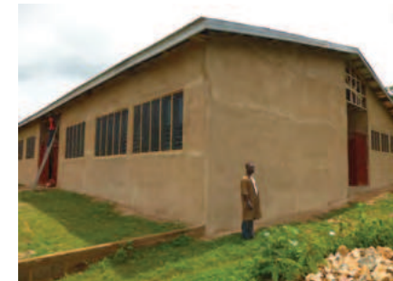
Der Rohbau des Kindergartens 2013 in Wusuta
